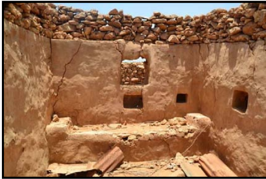
شكل (٣٤): شكل يوضح طلاء الجدران من الداخل.
