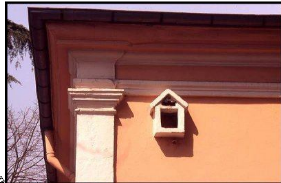
كل رقم (١٠) استانبول - سراي إسحاق باشا (١٠٩٥-١٠٩٦هـ/١٦٨٤-١٦٨٥م) - الواجهة الجنوبية
